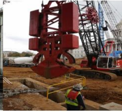
کلامشل در حال عملیات در خاک
