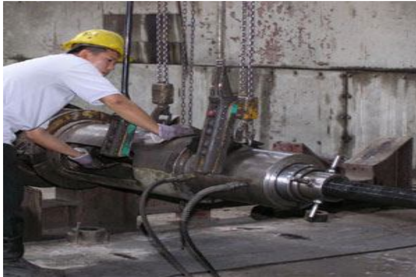
شکل ۱۰_۱۱: کشش آرماتورهای پیش تنیدگی
