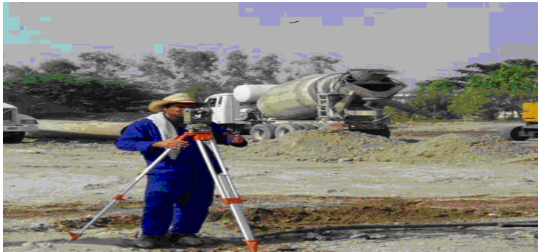
شکل ۲-۲. عملیات نقشه برداری
