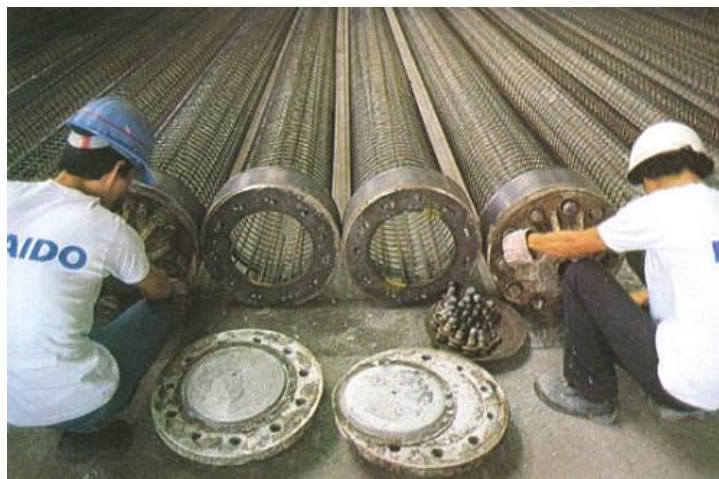
شکل ۱۰_۵: اتصال صفحات انتهائی به قفسه آرماتور
