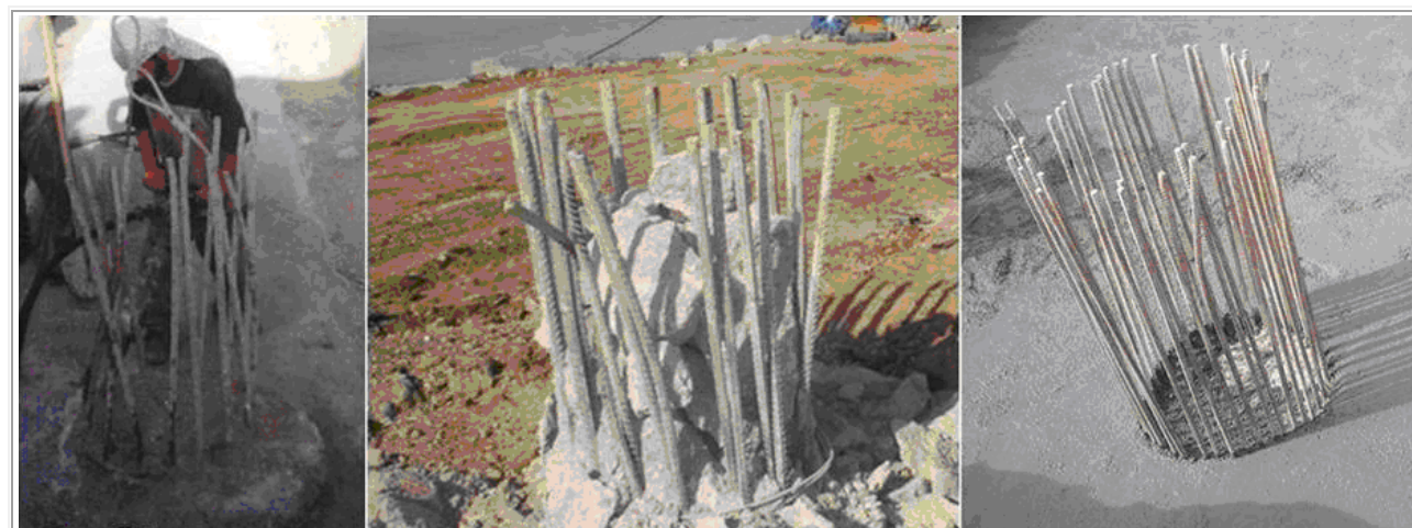
تخریب بتن کثیف روی شمع بعد از ۷ روز
