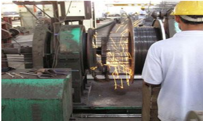
شکل ۱۰_۳: ساخت قفسه آرماتور
